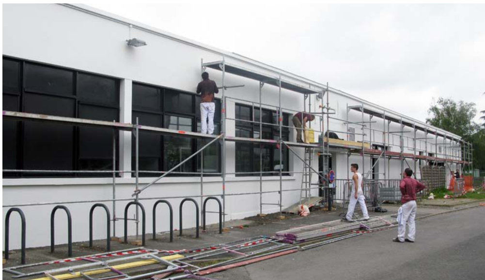
Ravalement de façade du Jardin Moderne - été 2015
